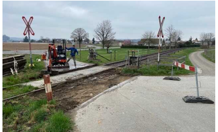
Die morschen Holzbohlen sind ausgebaut. (Foto: Franz Signer)
