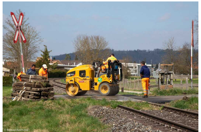
Als letzter Schritt erfolgte der Tragschichteinbau. (Foto: Richard Behrbohm)
